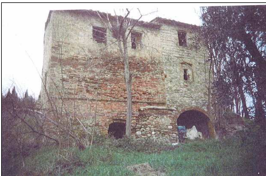
Particolare fabbricato in esame
