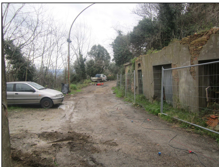
Via di Fondaccio con vista fabbricato parzialmente demolito
