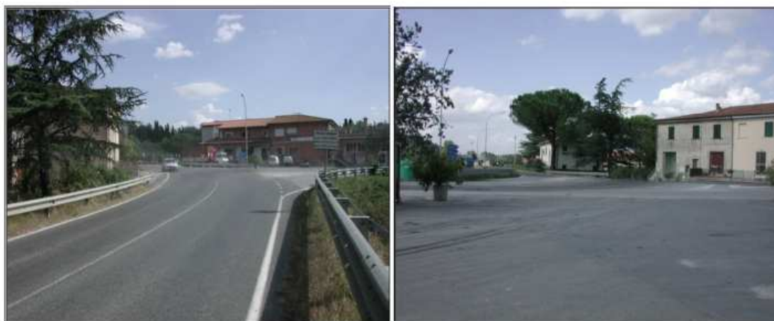
Figura 3- Vista da nord (sx) e sud-ovest (dx) dell'intersezione
