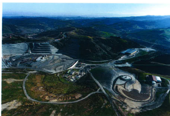
Figura 3-1 L'impianto di Belvedere a Legoli
